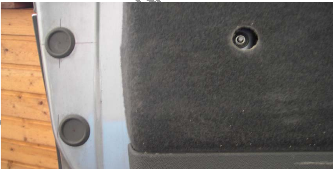
Abbildung 3: zusätzliche Bohrung im montierten Zustand, links
